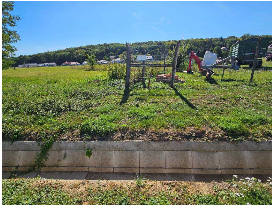
A volt vezető árok (szemben a magasabb fűvel benőtt területű) indulásának egykori helye és a mai vízvezetés kialakítása (beton árok)
