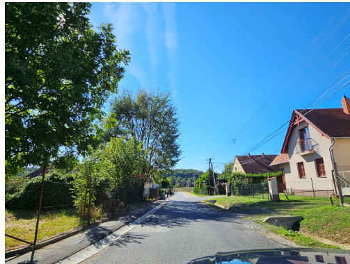
Rajki utca megújult csapadékvíz-elvezető rendszere
